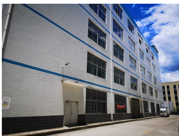
项目北面厂房
