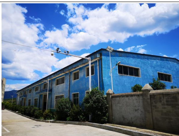
项目南面厂房
