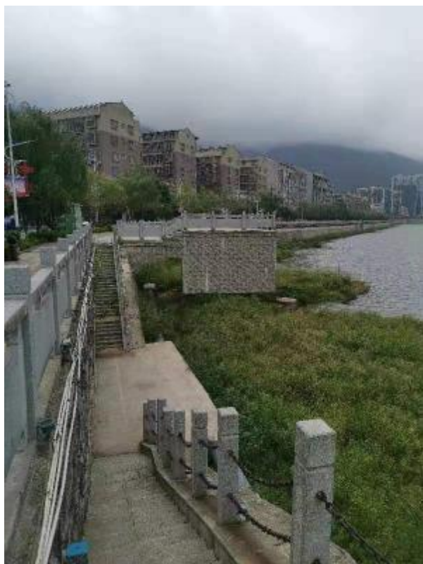
图 5.5-1 五一桥泵站现状
