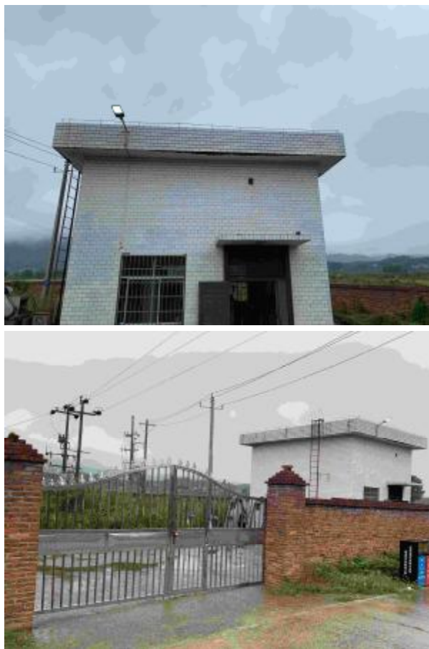
图 5.5-3 庙里泵站现状
