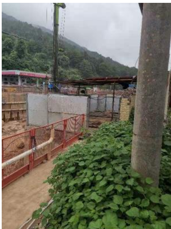
图 5.5-2 老城泵站现状（未迁址）
