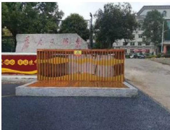
图 5.5-4 南岭泵站现状
